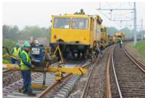
Longs Rails soudés sur traverses béton
