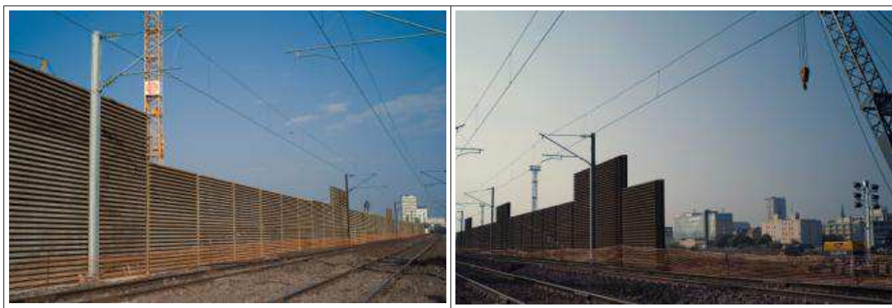
Figure 3 : écrans acoustiques à Metz.
